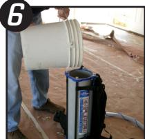
A continuación, llene el tanque hasta un  $\frac{3}{4}$  de su capacidad con compuesto de yeso. Inserte el pistón en el tanque y empuje hacia abajo hasta que esté situado sobre la pasta. Es
