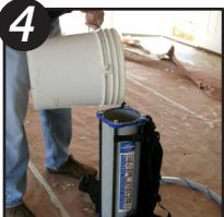
Luego, llene el tanque hasta un  $\frac{3}{4}$  de su capacidad con compuesto de yeso vertiendo la pasta mezclada en la parte superior de la tapa. Inserte el pistón en el tanque y apriete hasta que esté situado sobre la pasta. Es posible que necesite torcerlo o sacudirlo un poco para hacer salir el aire atrapado entre la pistola y la pasta.
