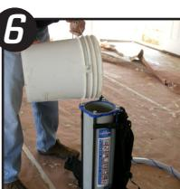
Ensuite, remplir le réservoir aux ¾ d'enduit pour cloison sèche. Placer le piston dans le réservoir et l'enfoncer jusqu'à ce qu'il repose sur le dessus de l'enduit. Un léger mouvement de rotation ou d'oscillation peut être nécessaire pour libérer l'air piégé entre le piston et l'enduit.
